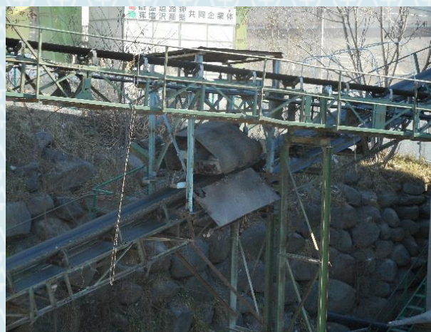
⑤ 磁選機により鉄筋を省きます
