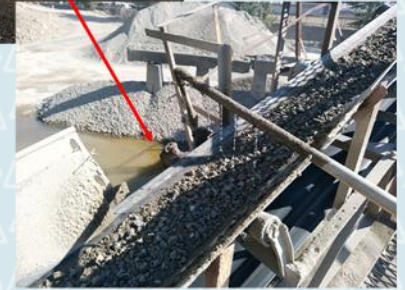
散水にて落ち口 粉塵対策
